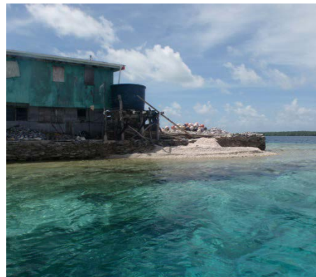
d. Seawall / Kaoa
